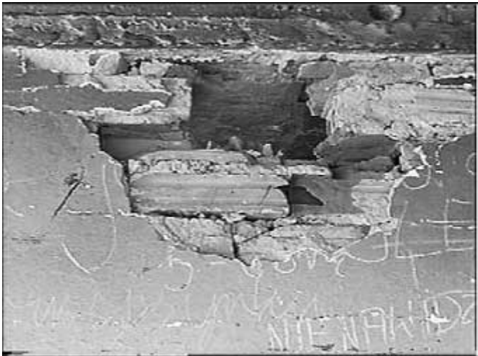
Hình 9: Tường bị phá hủy sau khi nổ bình trong không gian kín.
