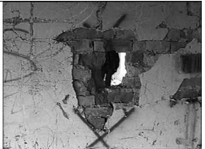
Hình 9: Tường bị phá hủy sau khi nổ bình trong không gian kín.
